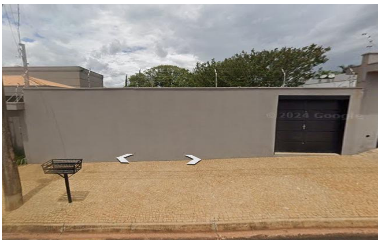
Figura 7- - Vista do imóvel da Quadra E – Lote nº 2, lado externo.
