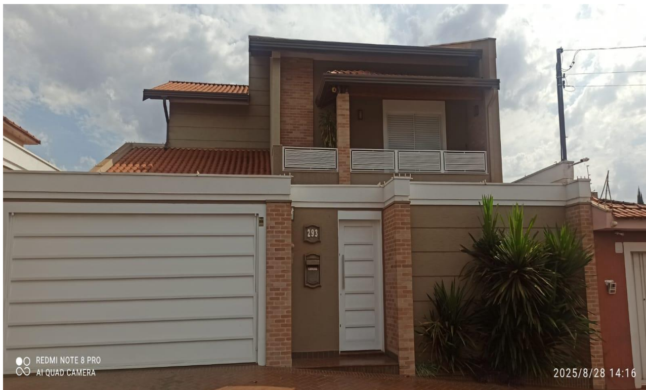
Figura 2- - Vista do imóvel da Quadra G – Lote nº 1.
