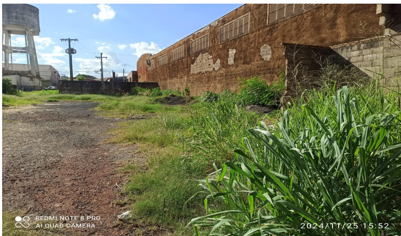
Figura 6: Lado de dentro do Imóvel da rua Santa Catarina, lote 150 – Matr. 14.744
