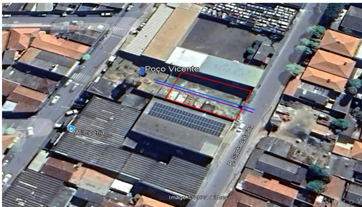
Figura 17: Posição onde estão instaladas as redes de abastecimentos de água potável.
