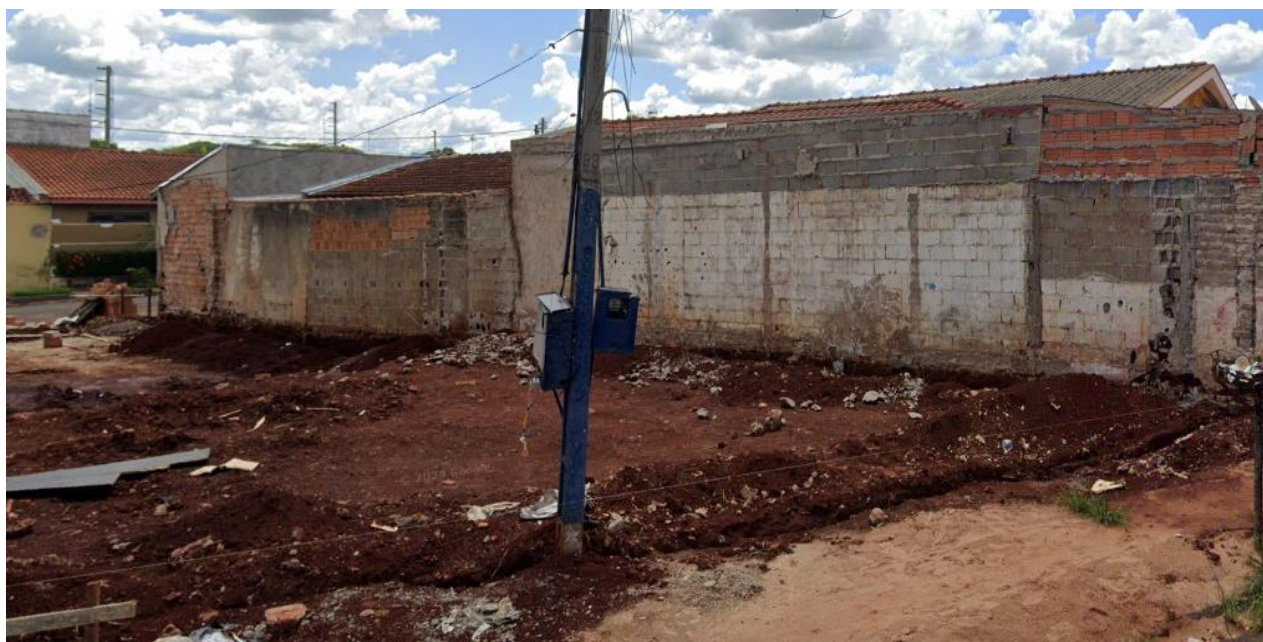
Figura 20: Imóvel 2: Rua Argerópolis Marques da Silva.
