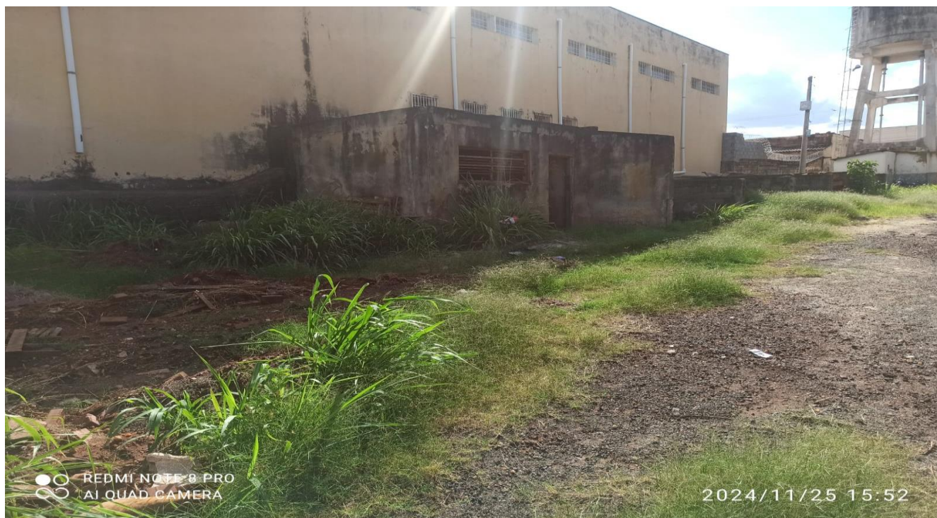
Figura 4: Lado de dentro do Imóvel da rua Santa Catarina, lote 160 – Matr. 14.745
