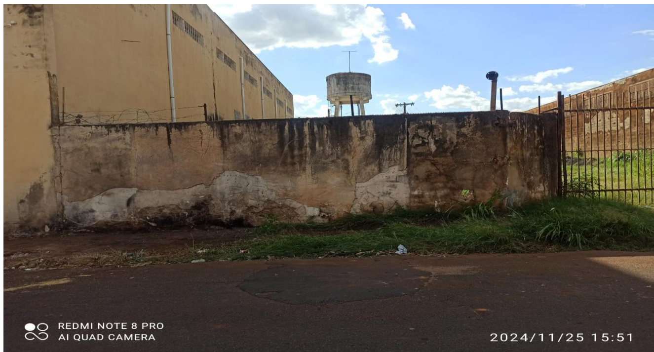
Figura 3: Frente do Imóvel da rua Santa Catarina, lote 160 – Matr. 14.745
