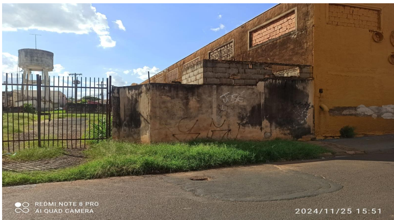
Figura 5: Frente do Imóvel da rua Santa Catarina, lote 150 – Matr. 14.744
